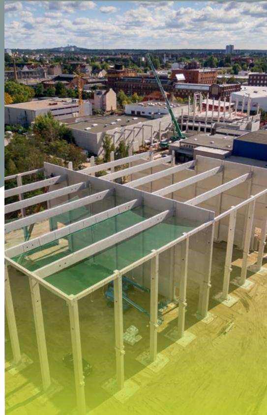
Individuell, wirtschaftlich, beständig: Spenner System steht für hochwertige, individuelle Fertigteile aus Stahlbeton. Die Elemente werden für jedes Bauvorhaben nach Kundenanforderung angefertigt. Neben Stützen und Wandelementen werden auch TT-Decken für hohe Nutzlasten hergestellt, die z. B. in Gewerbe- und Produktionshallen, Verbrauchermärkten, Bürogebäuden oder Sportstadien zum Einsatz kommen.
