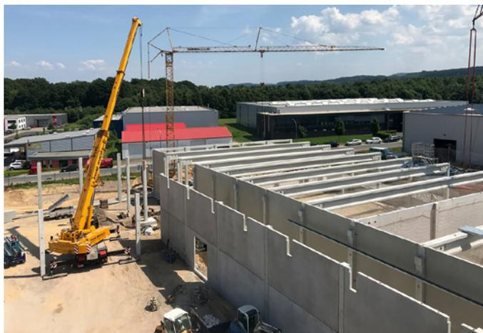
eine weitere Produktionshalle mit rund 6.000 m<sup>2</sup> Brutto-Nutzfläche. Dafür wurden ca. 300 Fertigteillemente mit einem Gesamtgewicht von rund 4.000 Tonnen verbaut. Unter anderem wurden dabei 100 Stützen mit angeformten Fundamentplatten sowie 35 Stück Spann-betonbinder bis zu einer Länge von 28 m eingebaut.
