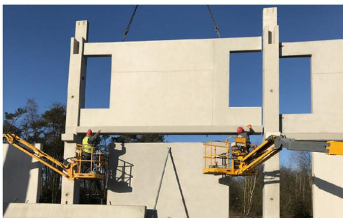
Schwerpunkte bilden Maschinenbau und Stahlbearbeitung. Für eine neue Produktionshalle liefert und montiert Syston 425 Fertigteile, davon rund 100 Stützen und 275 massive Wandelemente mit einem Gesamtgewicht von 4.000 Tonnen.
