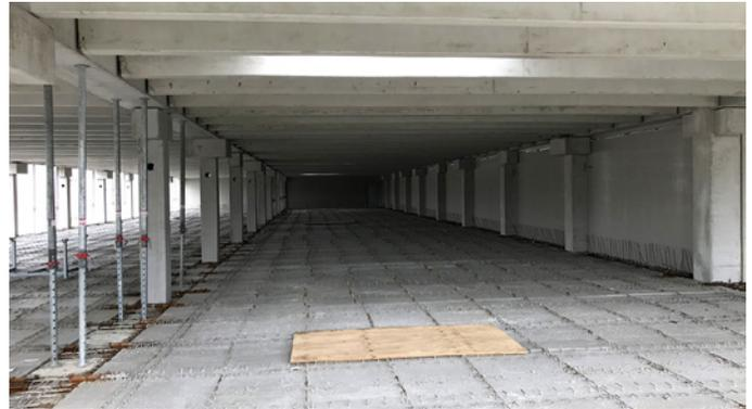
System eine neue zweigeschossige Lagerhalle mit einer Brutto-Nutzfläche von rund 9.000 m<sup>2</sup>. Es wurden 730 Fertigteilelemente mit einem Gesamtgewicht von ca. 6.000 Tonnen geliefert und montiert. 100 Stützen, 165 Unterzüge sowie 370 TT-Deckenelemente wurden verbaut.
