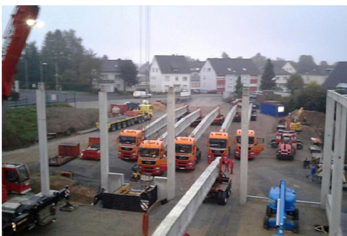
Für den Neubau der Logistikhalle wurden Fertigteilelemente mit einem Gesamtgewicht von ca. 7.950 Tonnen geliefert und montiert. Dabei wurde das Hallendach mit einer Spannweite von über 34 m konstruiert und mittels Syston Spannbeton-Satteldachbindern mit einem Einzelge-
