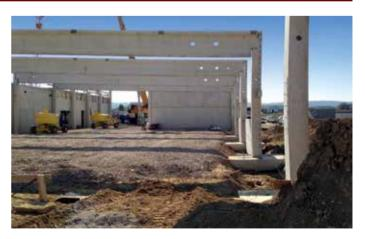
100 Fertigteile, davon 40 Stützen mit angeformten Fundament wurden sozusagen in die Nachbarschaft des Bielefelder Werkes geliefert.
